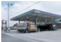
コージェネレーションシステムを導入したフリートSS
