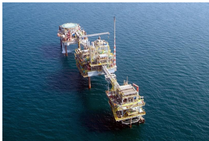
カタール石油開発洋上施設
