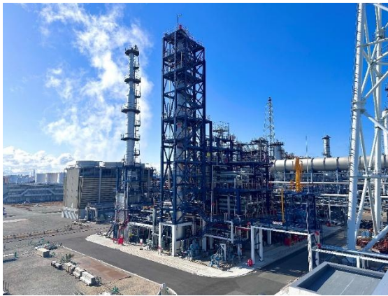
完工した SAF 製造装置 (コスモ石油堺製油所構内)
