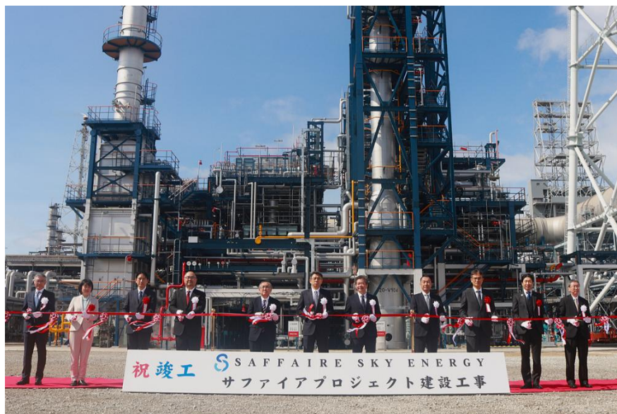
竣工式の様子（事業者及びご来賓によるテープカット）
